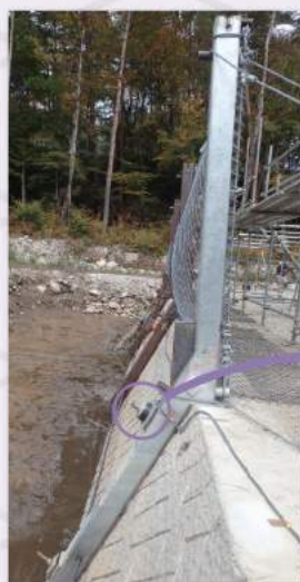
支柱設置状況
